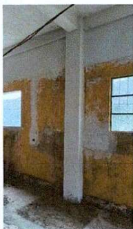
Foto1: Columnas de reforzamiento de paredes que sirven de muro perimetral finalizados.
