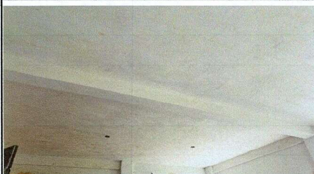
Foto 2: Mantenimiento de losa con aplicación de material y monocapa, finalizado.
