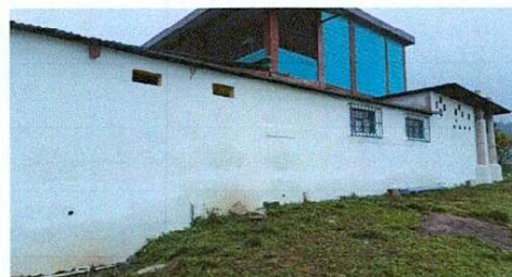
Foto 4: Mantenimiento de paredes que sirven como muro perimetral con la aplicación de monocapa en el área de cocina, baños y dirección. Finalizado.
