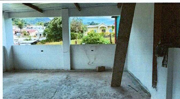
Foto 6: Remodelación del aula segundo nivel, finalizado.
