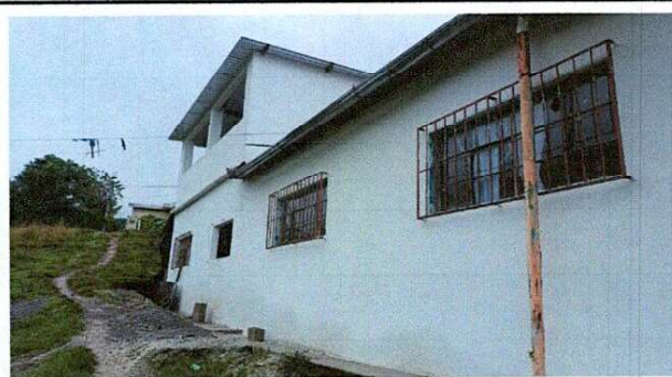
Foto 5: Mantenimiento de paredes, que sirven como muro perimetral, de las áreas de salones de clases. Finalizado.
