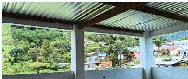
Foto 3: Instalación de del techo de láminas en la remodelación del aula del segundo nivel, finalizado.
